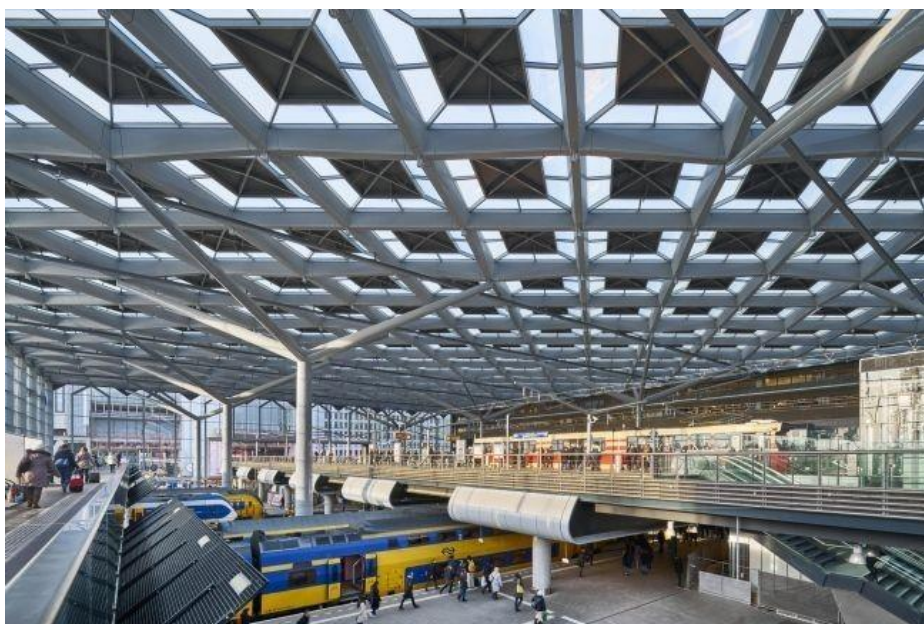
Рисунок 28 - Вид на навесную плиту вокзала. [10]
